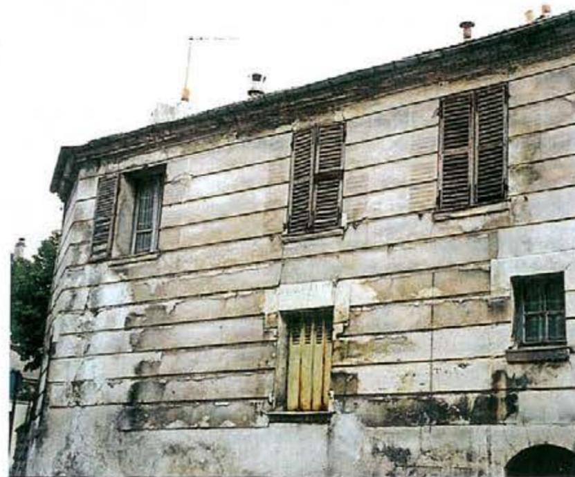
*Moellons enduits au mortier de plâtre et chaux, avec faux-joints d'appareil.*
