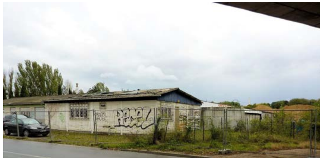
La parcelle BI 57, vue de sous le viaduc du RER
