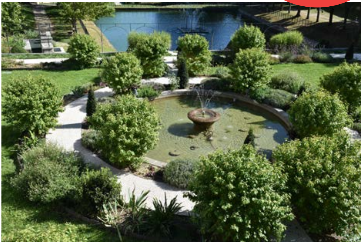
Fin de travaux - Allées du jardin « à la française »
