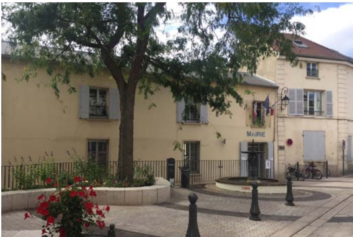
Après travaux - Septembre 2019
