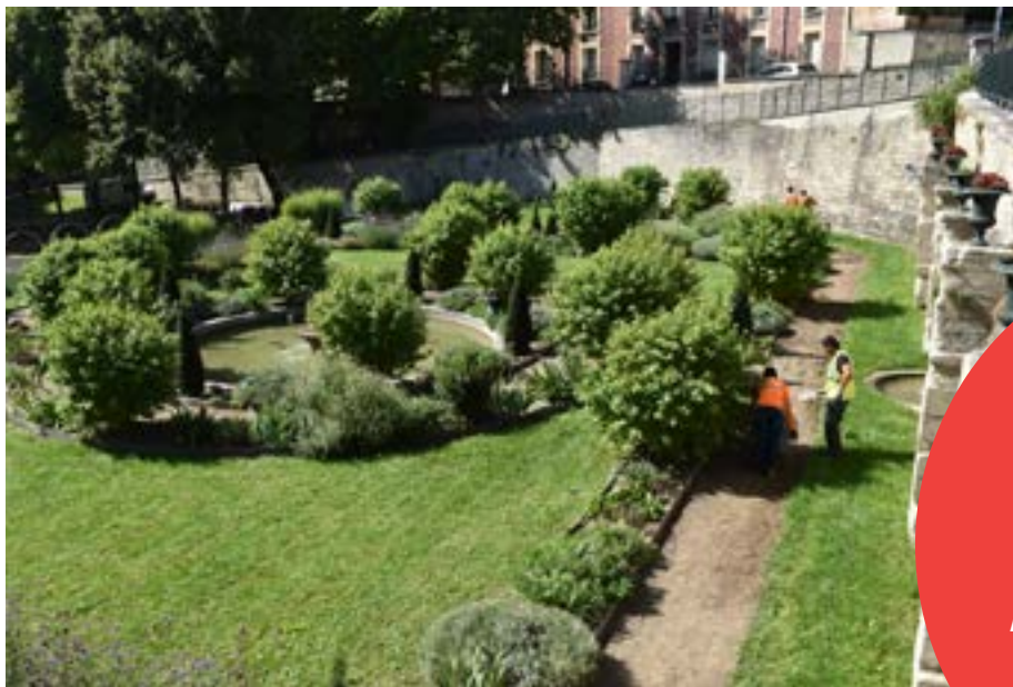
Travaux de requalification des allées du jardin « à la française »
