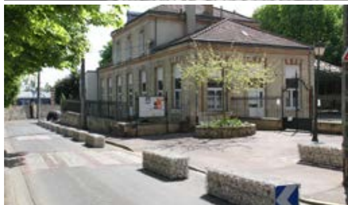
Installation de gabions devant une école - plan Vigipirate
