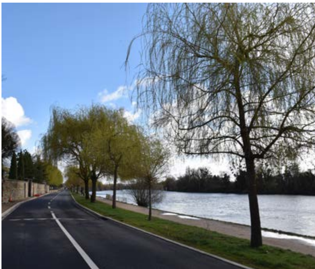
Après travaux - Juin 2019
