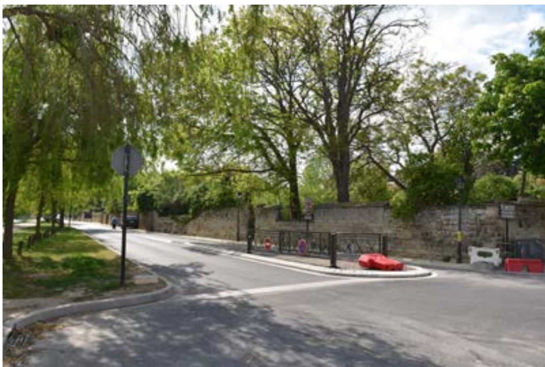
Après travaux - Juin 2019
