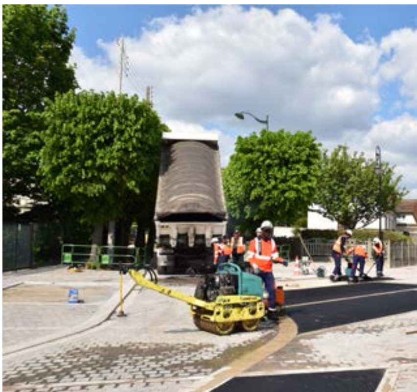
Travaux de finition - Avril 2019
