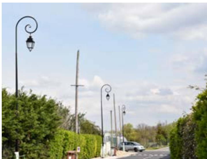
Renouvellement de l'éclairage public - Rue de Seine
