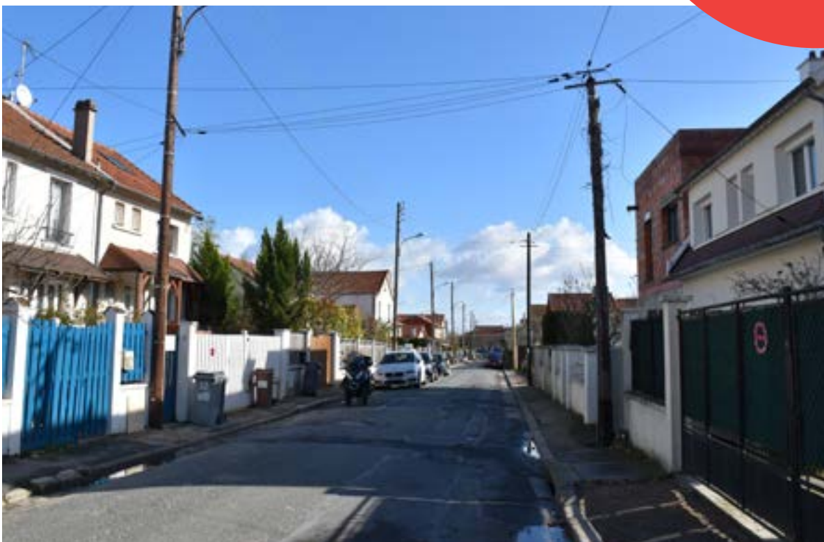
Travaux en cours - Mars 2019
