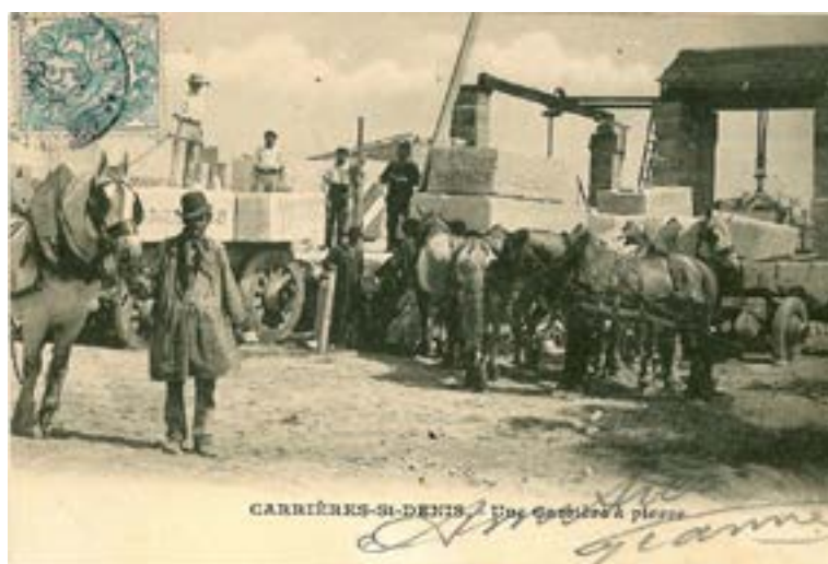
Extraction de pierres dans une carrière
