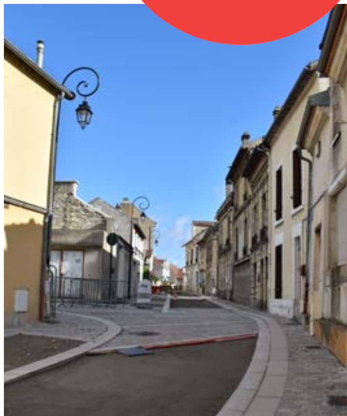
Pendant travaux - Mars 2019
