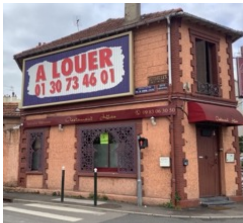
Publicité de plus de 12m 2 installée sur mur non-aveugle
