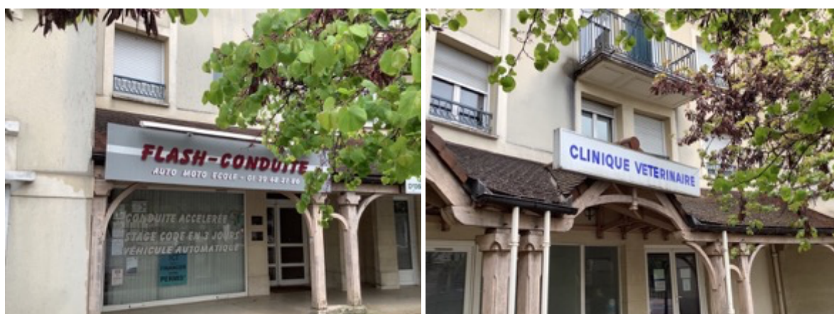
Enseignes parallèles au mur dépassant des limites du mur et/ou de l'égout du toit, Carrières-sur-Seine, mai 2021.
