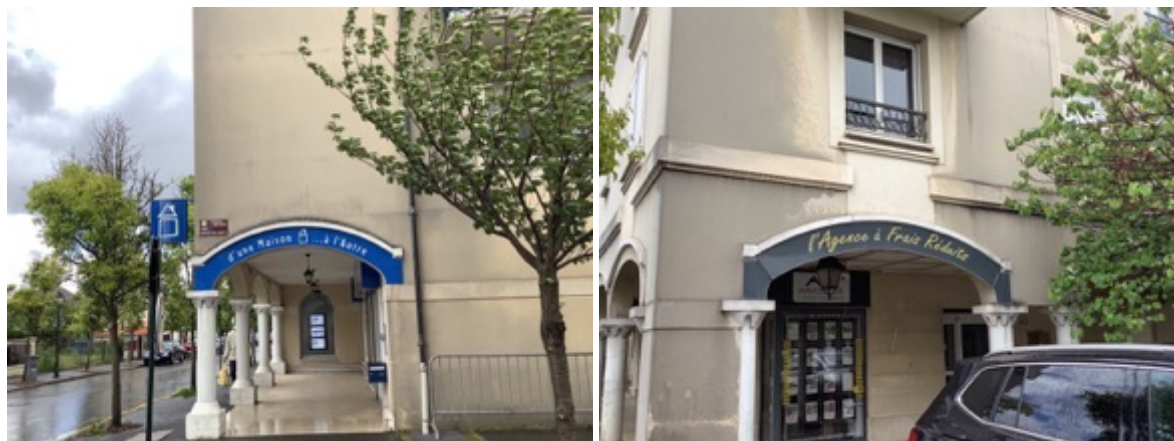
Enseignes parallèles au mur respectant l'architecture atypique du bâtiment, Carrières-sur-Seine, mai 2021.
