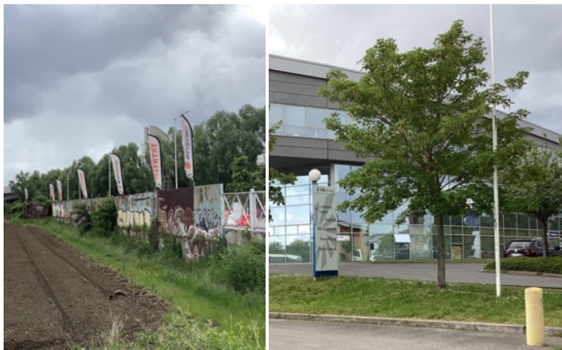
Enseigne scellée au sol de type « drapeau » et enseigne scellée au sol de type « totem ». Carrières-sur-Seine, mai 2021.
