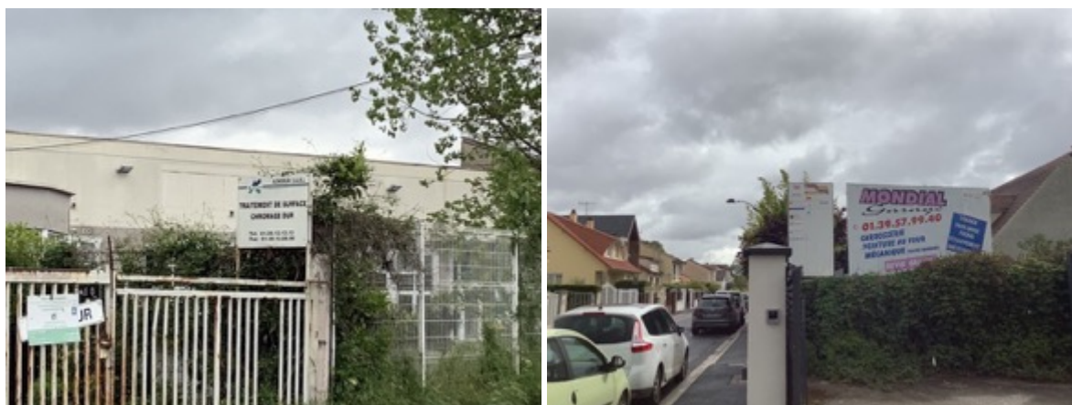
Ensignes scellées au sol ne respectant pas la règle dite « H/2 ». Carrières-sur-Seine, mai 2021.
