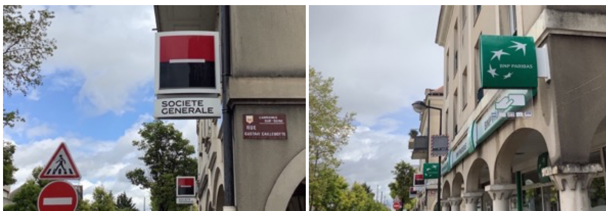
Enseignes perpendiculaires au mur en nombre important pour signaler une même activité et avec un impact sur les bâtiments sur lesquels elles sont installées, Carrières-sur-Seine, mai 2021.
