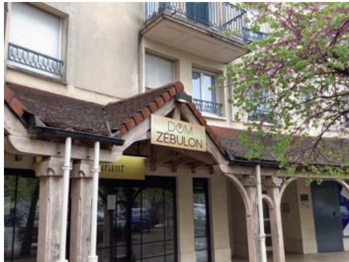
Enseigne dépassant des limites de l'égout du toit. Carrières-sur-Seine, mai 2021.
