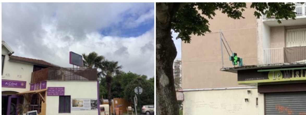
Enseignes sur toiture ou terrasse en tenant lieu. Carrières-sur-Seine, mai 2021.
