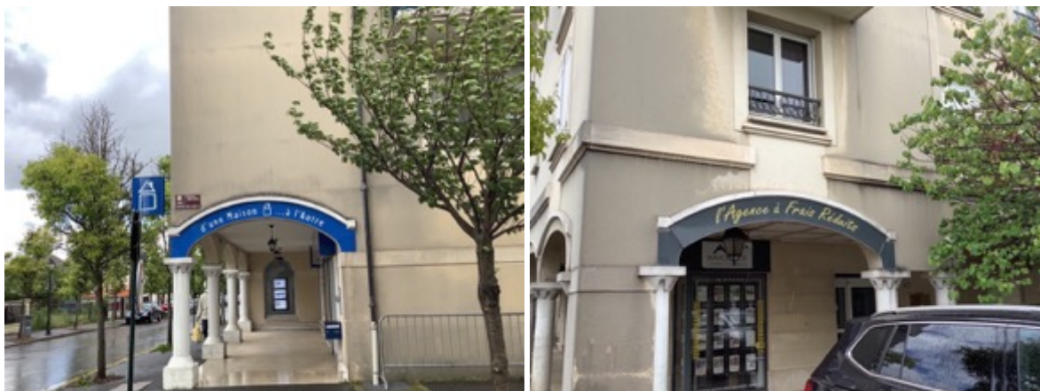
Ensignes parallèles au mur respectant l'architecture atypique du bâtiment, Carrières-sur-Seine, mai 2021.
