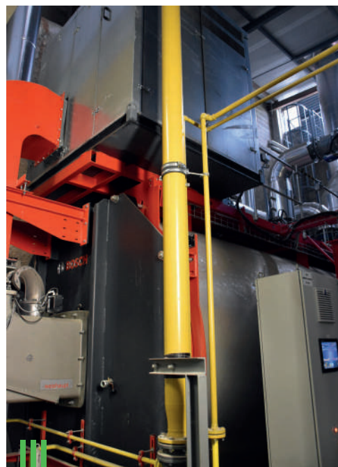
L'une des trois nouvelles chaudières gaz (de secours) d'une puissance de 13 MW.
