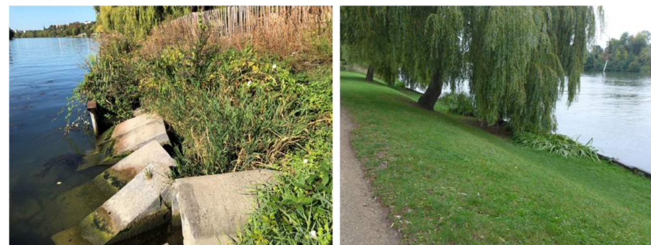
Figure 7 : Principales morphologies des berges au droit des aménagements : blocs et palplanches (Biotec 2020 et 2021)
