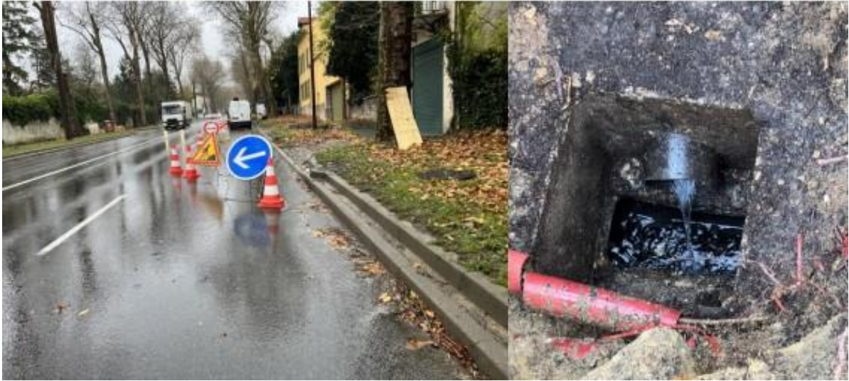
Figure 33 : Réparation de boîte de branchement au 18 route de Versailles
