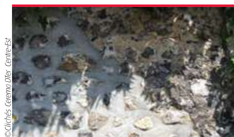
Rejointoiement de la maçonnerie d'un parement
