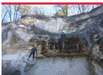
Pose d'un filet métallique, Bourgogne.
