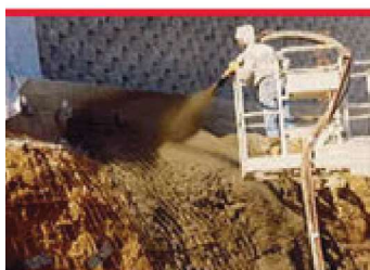
Mise en place de béton projeté.
