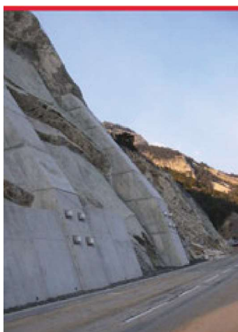
Mur de confortement et tirants en pied, Modane, Savoie.
