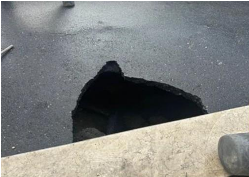
Figure 33 : Affaissement au 10 rue du Moulin
