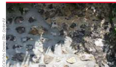
Rejointoiement de la maçonnerie d'un parement
