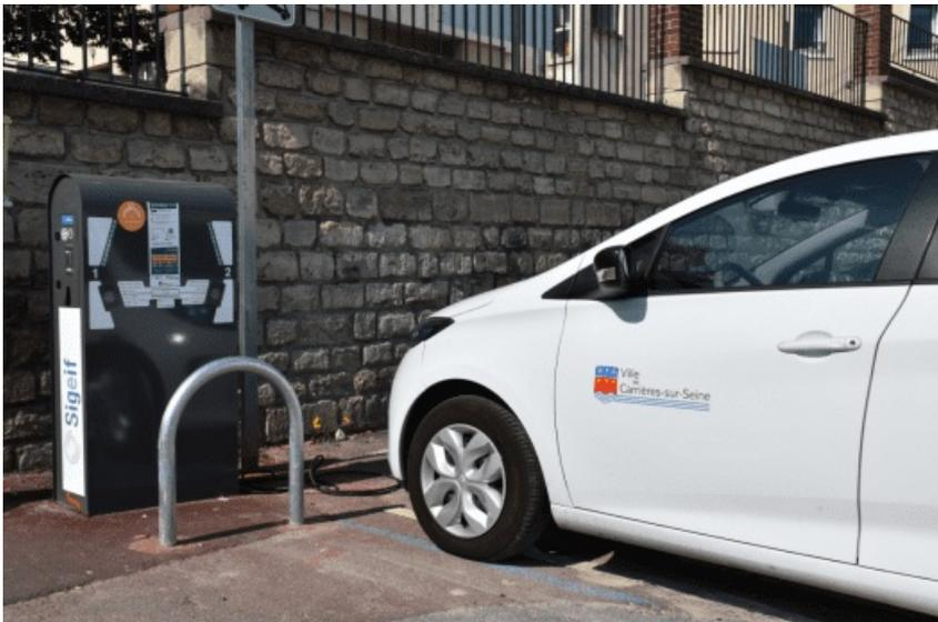
La puissance maximale délivrable par la borne est de 22 kilowatts. L'énergie délivrée reste néanmoins dépendante de la capacité de chaque véhicule.
